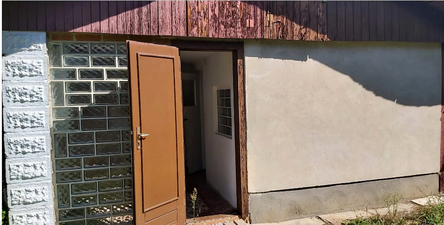
Nebengelass (hinter dem Haus) mit Aufenthaltsraum, WC und Wäscheraum
