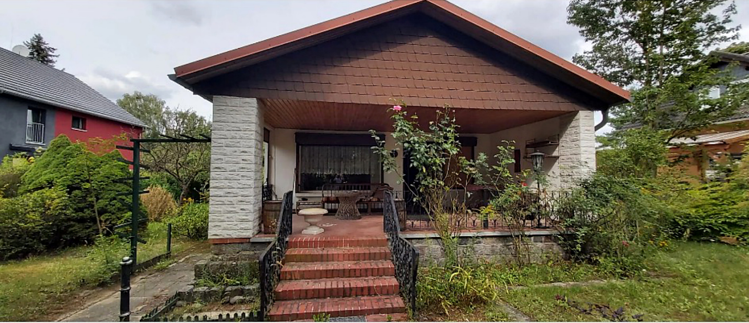
Blick auf die Terrasse
